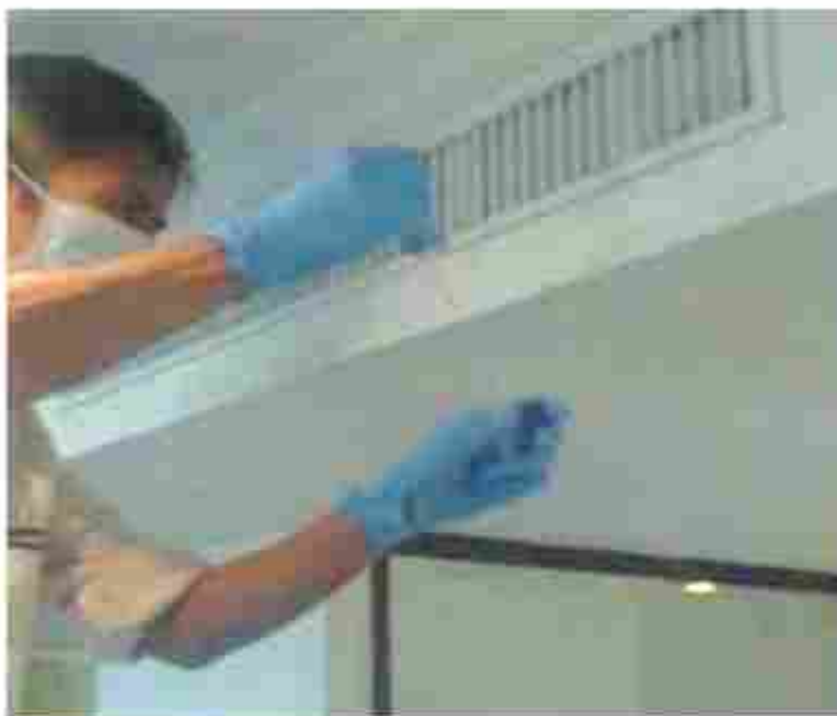
Gambar 5. 11 Pengambilan Swab Biofilm di AC Sentral
